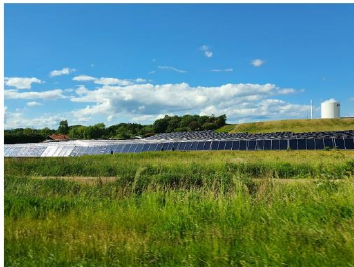
Et solvarmeanlæg ved den sjællandske motorvej.
